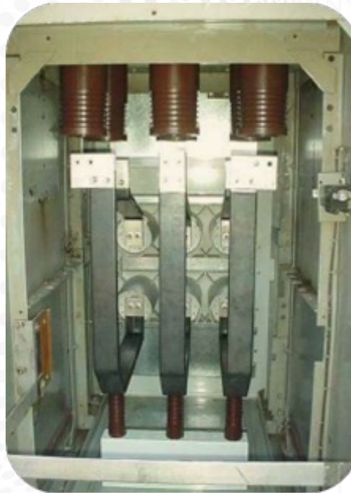
BARREADO DE ADAPTACION. ACCESO SUPERIOR CON PASAMUROS
