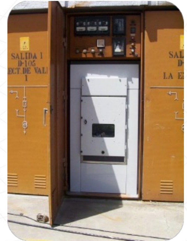
INTERRUPTOR SUSTITUIDO
