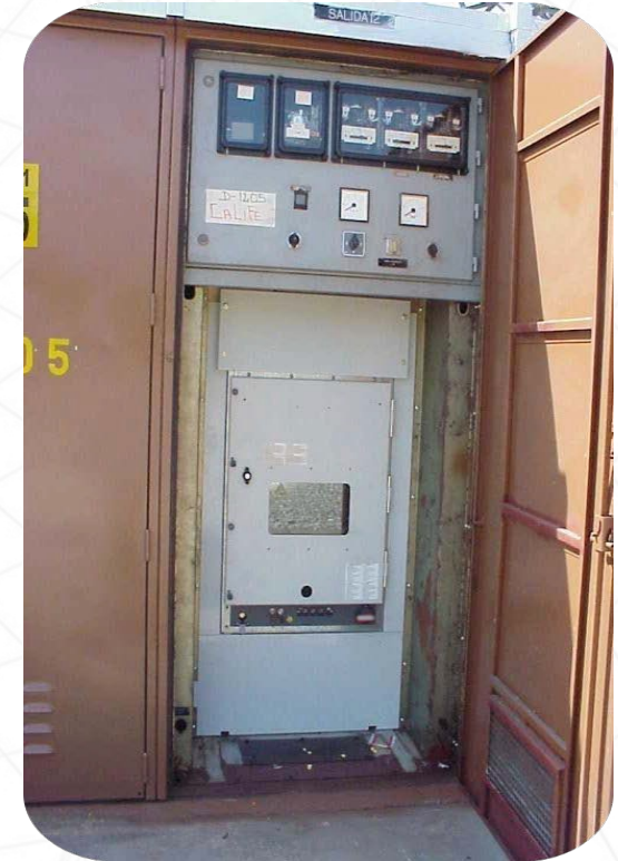
INTERRUPTOR SUSTITUIDO
