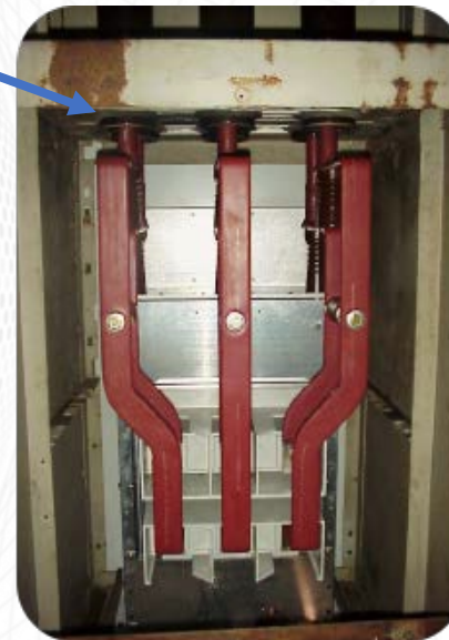
ADAPTACION DE BARREADO CON BARRAS CILINDRICAS PARA APROVECHAR EL SISTEMA DE ANCLAJE EXISTENTE
